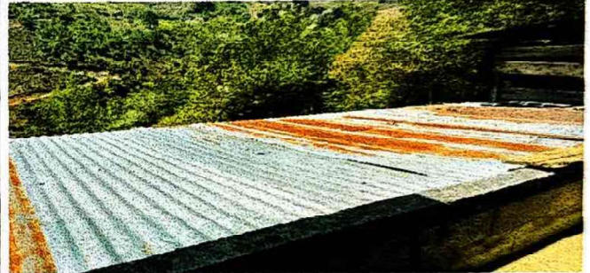
Foto 4: CONDICIÓN DEL TECHO DE LA COCINA
