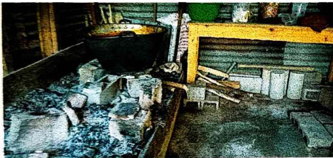
Foto 3: CONDICIÓN DEL POLLETÓN DE LA COCINA
